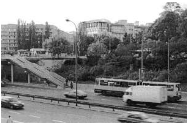
Ryc. 92a. Widok na plac na Rozdrożu w 2003 roku (fot. J. Rylke)
