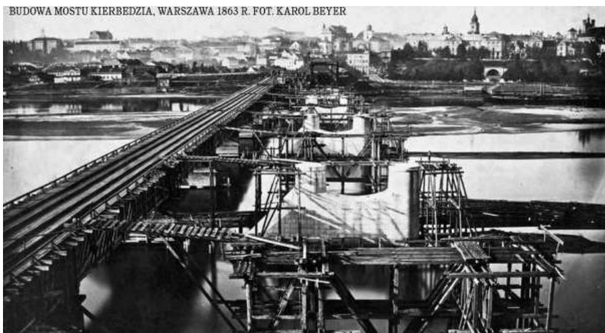
Ryc. 44. K. Beyer. Budowa mostu Kierbedzia, 1863
